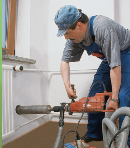
Bohrung für die Montage des schalldämmenden Lüfters
