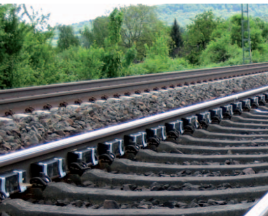
Schienenstegdämpfer bei einem Regelloberbau mit Schotterbett im Mittelrhein
