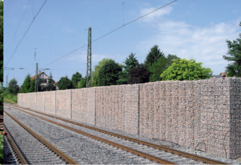
Gabionen-Schallschutzwand mit Naturstein befüllt
