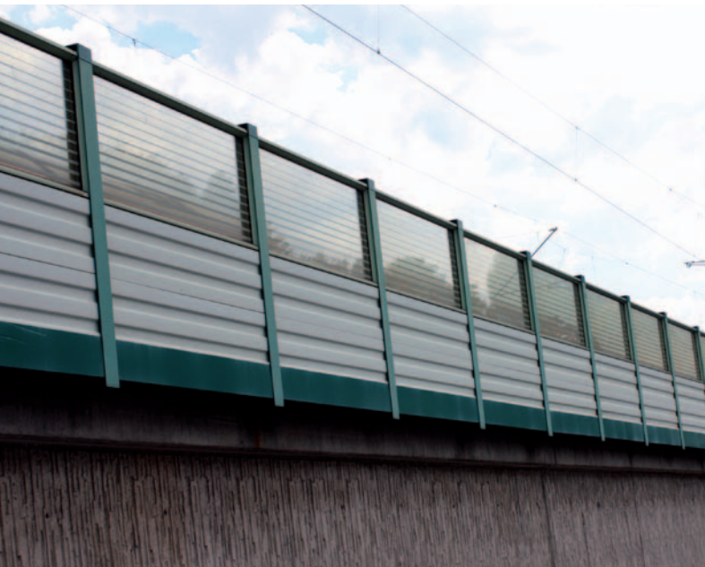
Schallschutzwände mit durchsichtigen Elementen aus Glas in Rolandswerth (links) und Bremen-Walle (rechts)
